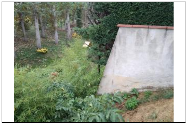
Hauteur atteinte au niveau du mur de clôture
