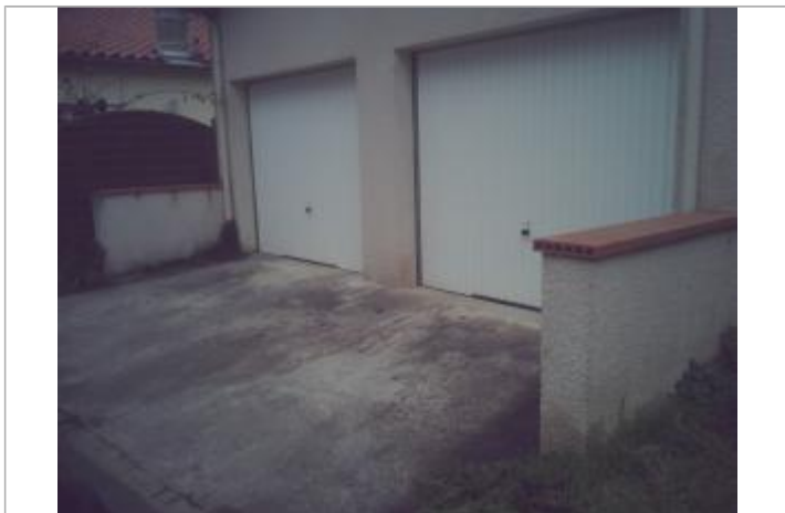
Garages lors du relevé topographique - trace encore visible sur le crépis - décembre 2019
