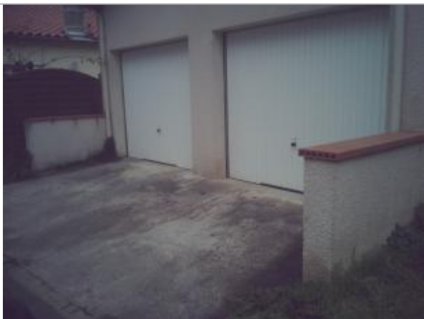
Garages lors du relevé topographique - trace encore visible sur le crépis - décembre 2019
