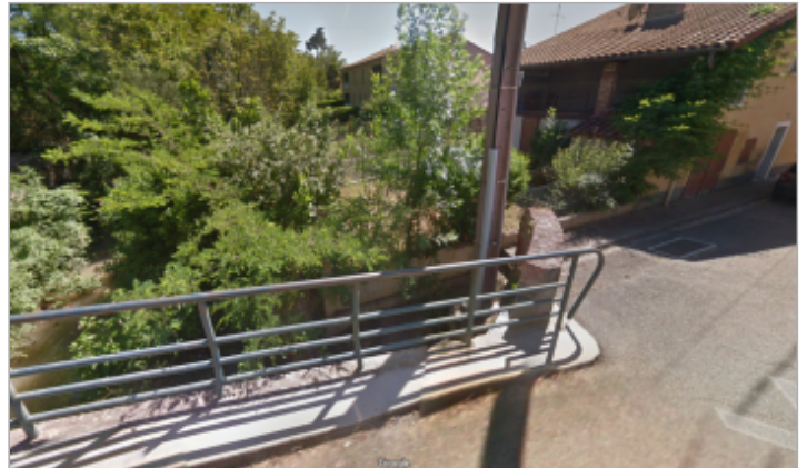
Pont sur le Calers -Vue du site avant la crue de juillet - juin 2018 [ (c) Google]
