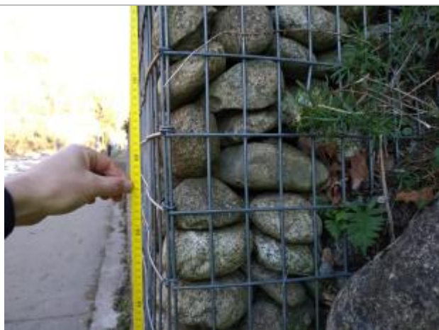
Relevé de hauteur d'eau, 157cm au dessus du sol
