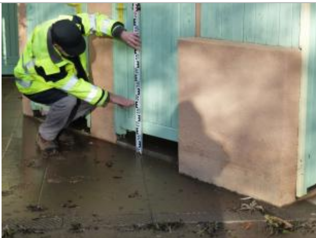
Hauteur atteinte par l'eau- environ 40cm - [(c) DDT09]
