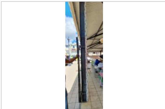
Poteau de mesure des hauteurs de crue (06/11/15; 27/08/19; 31/10/19)
