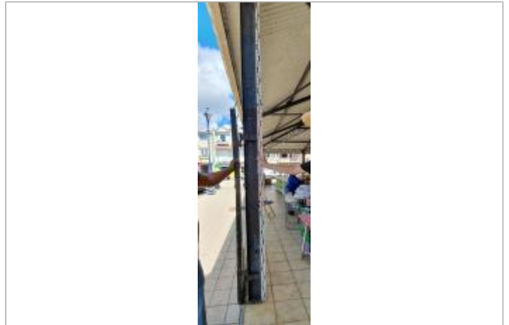
Poteau de mesure des hauteurs de crue (06/11/15; 27/08/19; 31/10/19)
