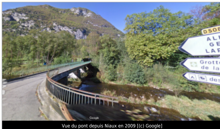
Vue du pont depuis Niaux en 2009 [(c) Google]
