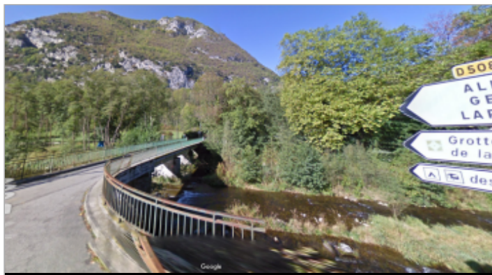
Vue du pont depuis Niaux en 2009 [(c) Google]
