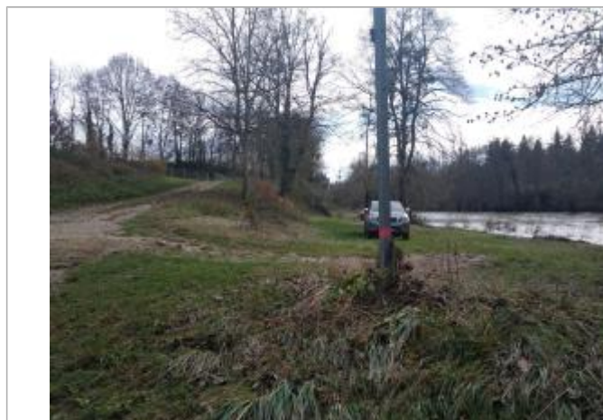
Hauteur atteinte sur le poteau (trait bombe) et laisse sur le chemin (à gauche)
