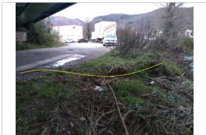
Hauteur atteinte au niveau de la rue - limite débordant
