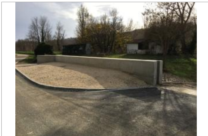
Vue du batardeau
