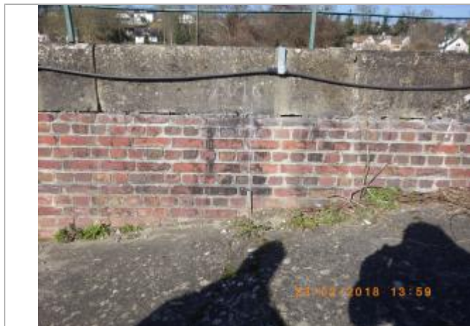
vue du repère (inscription "2016" et ligne verticale tracée à la craie, et cale de bois sur la cale) - photo SPC SACN
