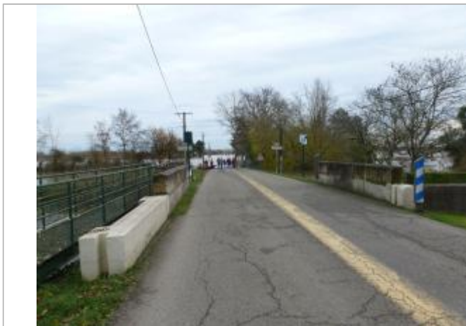
Photo prise à un niveau proche du maximum de la crue
