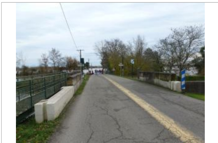
Photo prise à un niveau proche du maximum de la crue
