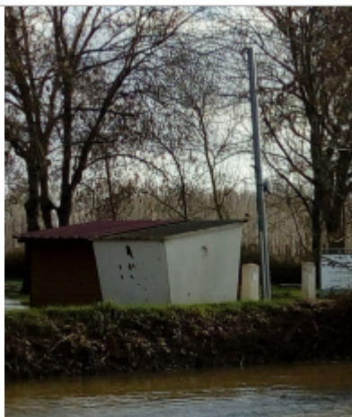
Marque de laisse de crue sur le poteau électrique
