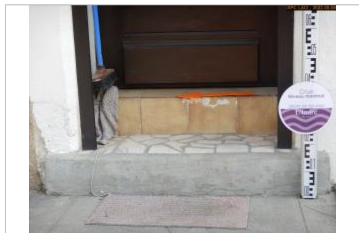
entrée du parking du restaurant (photo SPC SACN)
