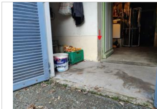
Vue de l'ancienne laisse au niveau de la flèche rouge sur mur façade ouest de la maison
