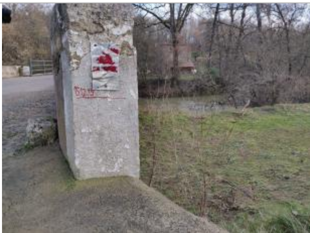
Vue pile amont du pont RG
