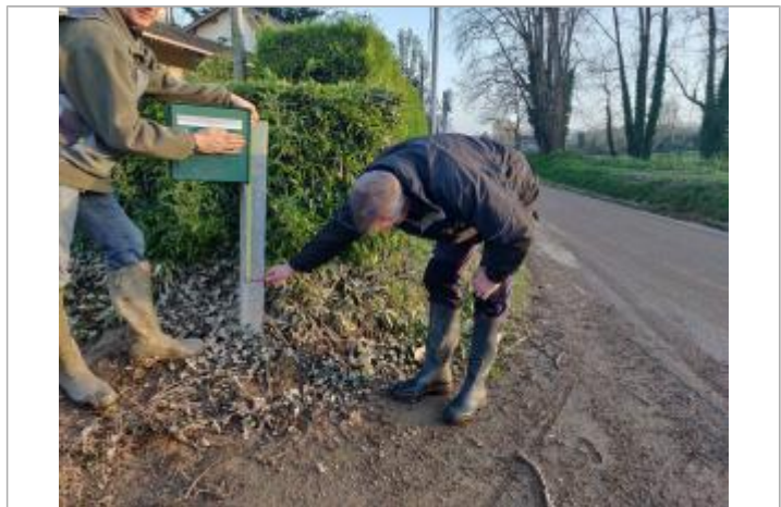
Laisse sur poteau en acier galvanisé maintenant la boîte au lettre
