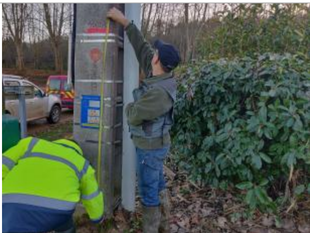
Laisse de crue sur poteau EDF à 1,78m du sol
