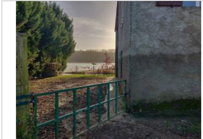
Vue partielle de la maison depuis le bord de la route communale
