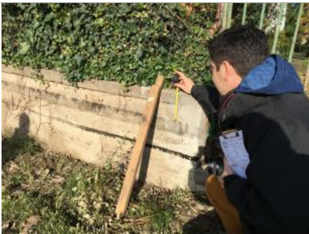
Vue de la marque 20 cm sous le haut du muret
