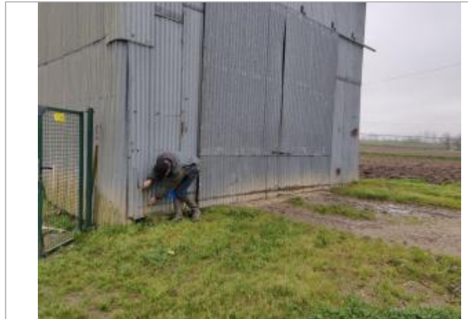
Hangar (métallique) lieu dit Perixou n°1
