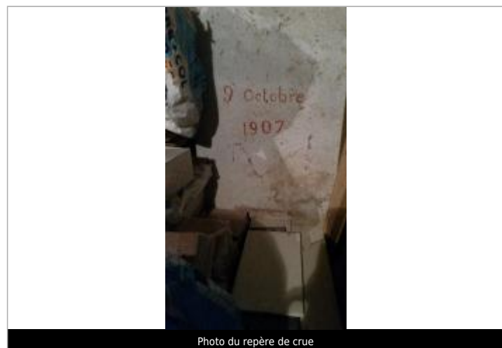
Photo du repère de crue
