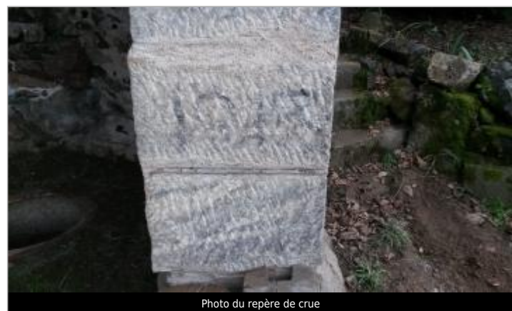
Photo du repère de crue
