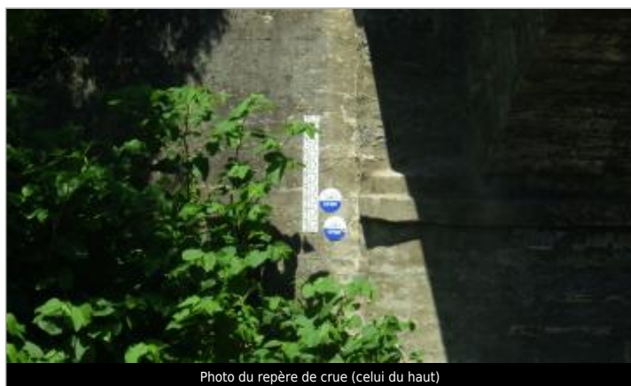
Photo du repère de crue (celui du haut)
