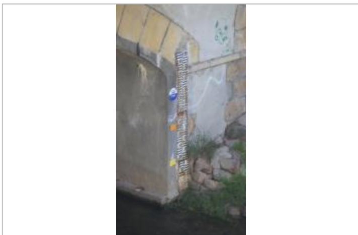
Photo du repère de crue à hauteur de l'échelle limnimétrique de Lamure
