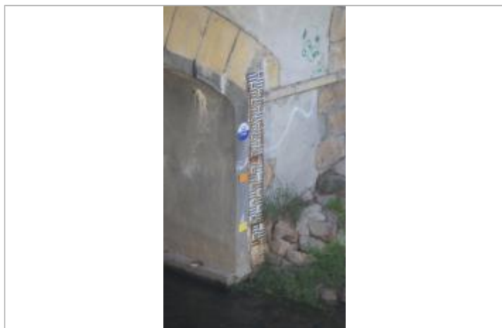
Photo du repère de crue à hauteur de l'échelle limnimétrique de Lamure
