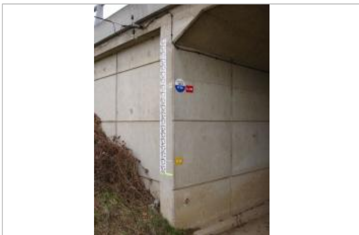
Photo du repère de crue
