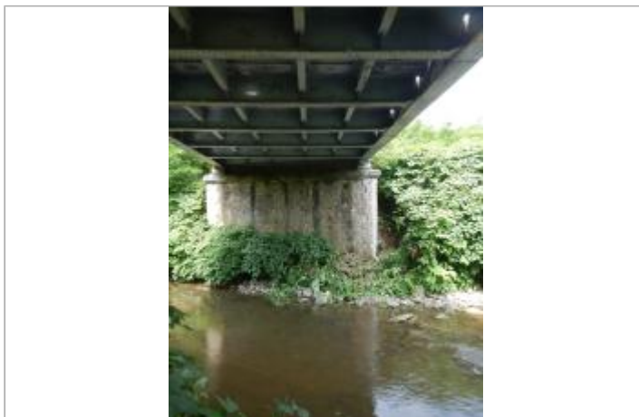
Echelle limnimétrique sur la culée en aval du pont (rive gauche)
