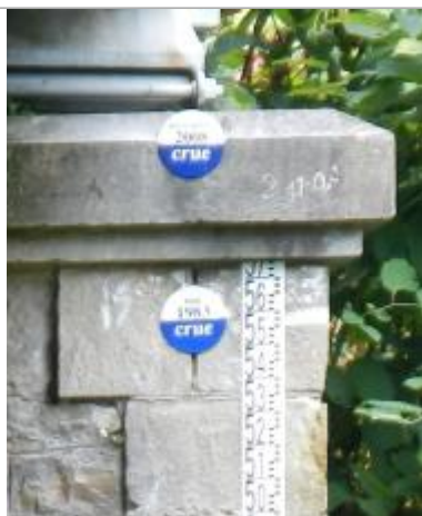
Photo du repère de la crue de 1983 (Plaque du bas)
