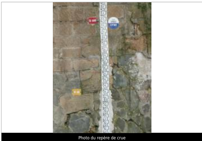
Photo du repère de crue
