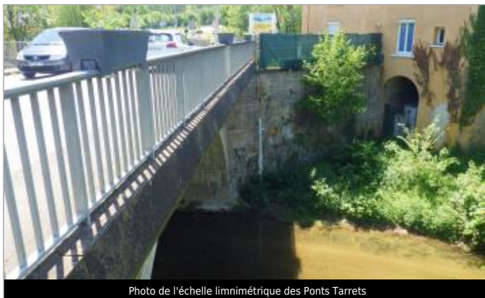
Photo de l'échelle limnimétrique des Ponts Tarrets
