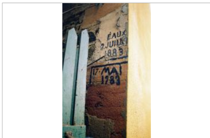
Photo du repère de crue
