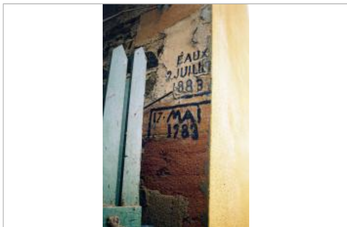
Photo du repère de crue
