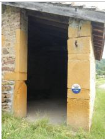
Photo du repère de crue
