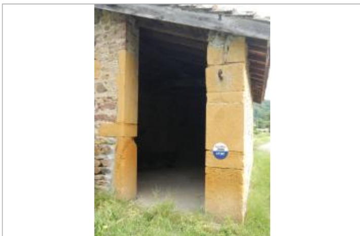
Photo du repère de crue
