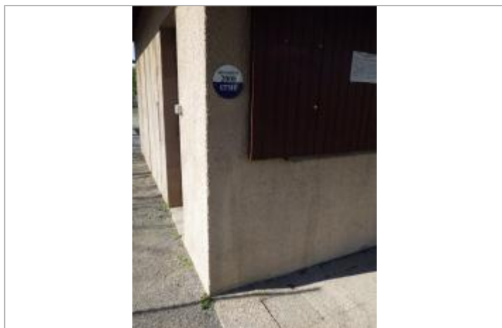
Photo du repère de crue
