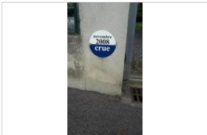
Photo du repère de crue
