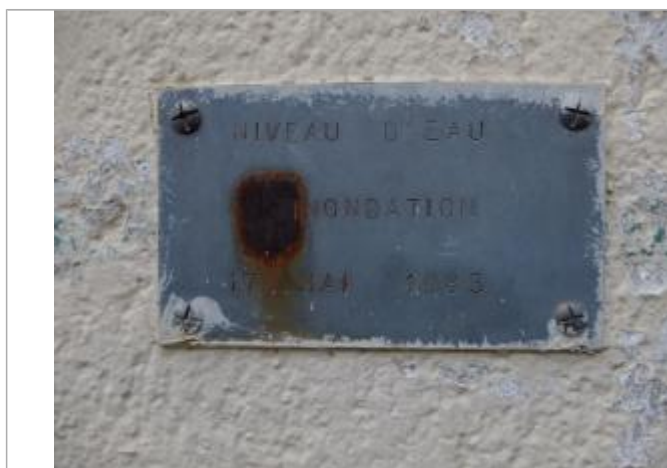
Photo du repère de crue
