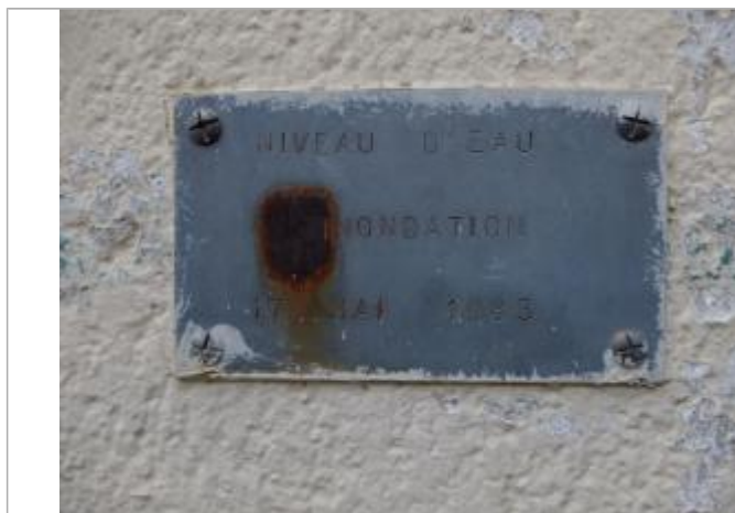
Photo du repère de crue
