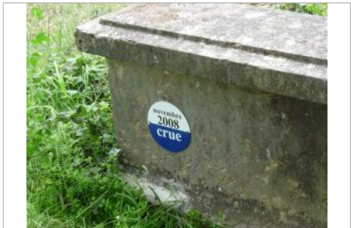
Photo du repère de crue
