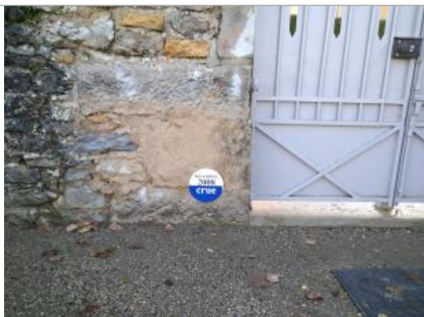
Photo du repère de crue
