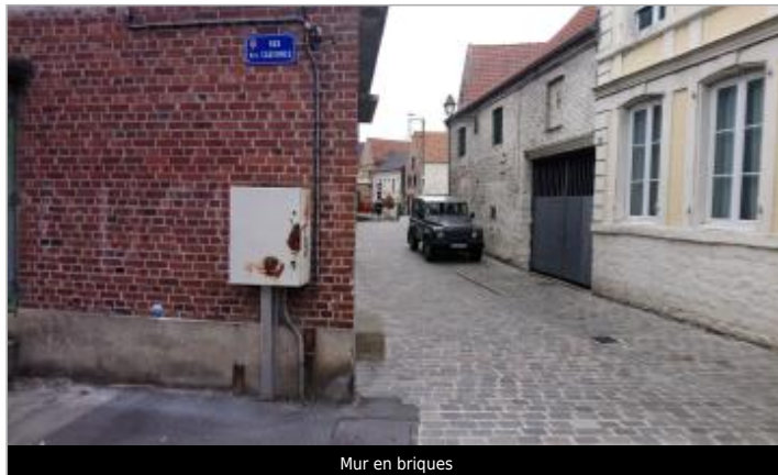
Mur en briques
