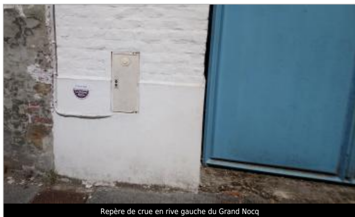
Repère de crue en rive gauche du Grand Nocq
