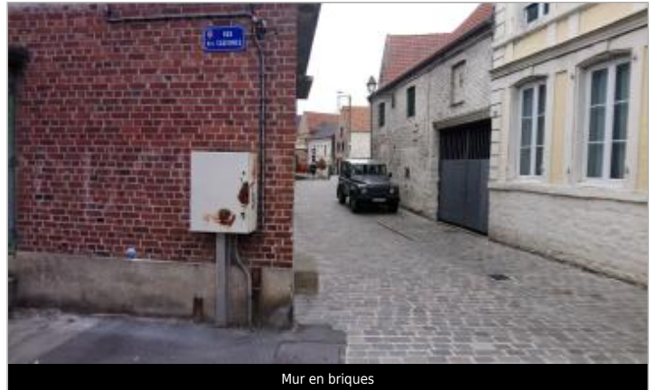
Mur en briques
