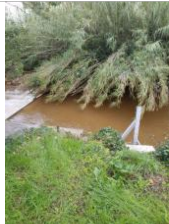
Vue du site - Auteur : Cerema Méditerranée
