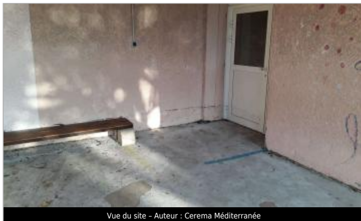
Vue du site - Auteur : Cerema Méditerranée
