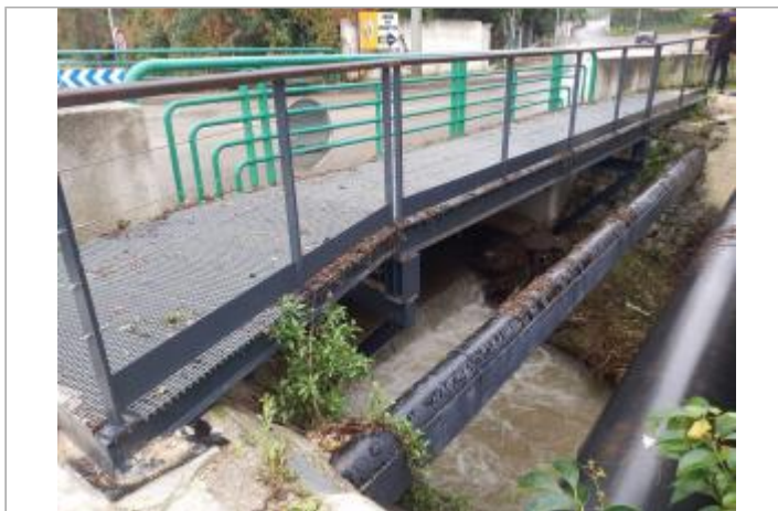
Vue du site - Auteur : Cerema Méditerranée
