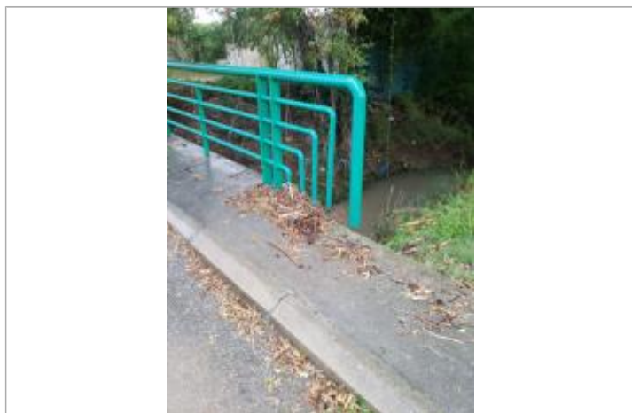
Vue de la PHE - Auteur : Cerema Méditerranée
