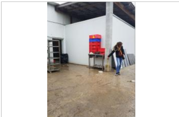
Vue du site - Auteur : Cerema Méditerranée
