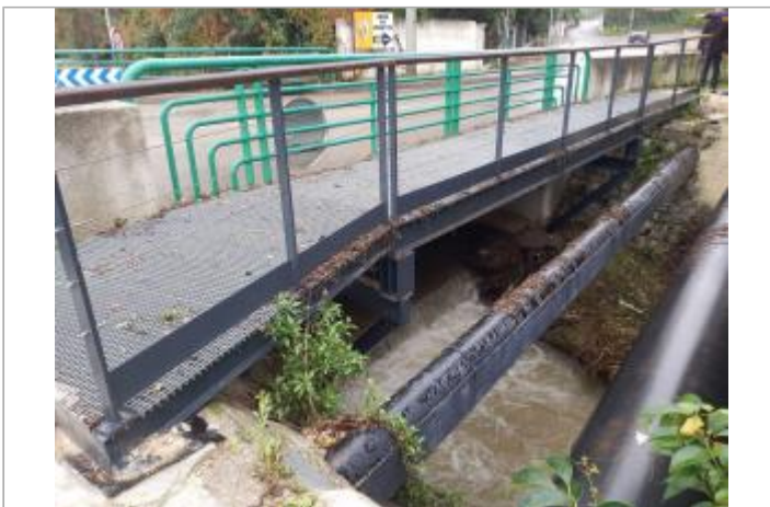
Vue du site - Auteur : Cerema Méditerranée
